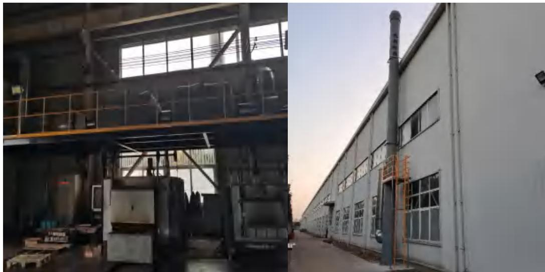
油淬废气处理装置（静电式油烟净化器+两级活性炭吸附装置+15m 高排气筒）
